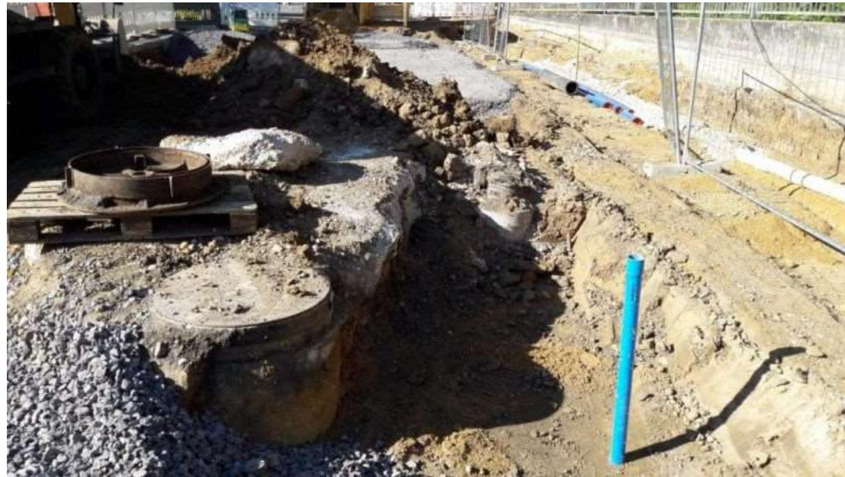
Betonauffüllungen im Bereich von Schachbauwerken
