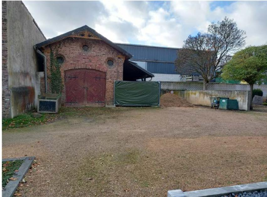
Giebelwand mit markanten Ziermerkmalen aus vorgesetzten Ziegeln. Durch Tönung der Zierfuge und mauerbündiger Verfugung ein geschlossenes und einheitliches Gesamtbild.
