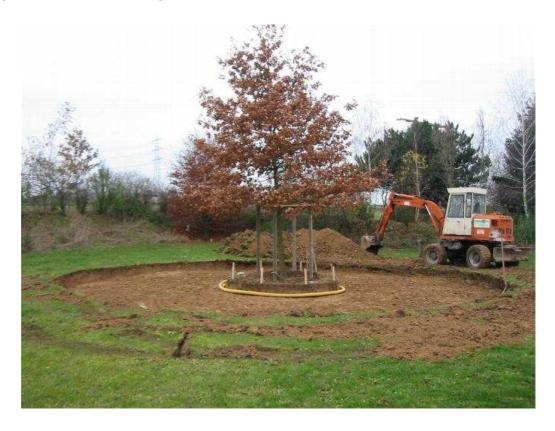
**SETZEN DER KAMMERN** Es werden mit einem Erdbohrer (Durchmesser 28-30 cm) 44 Löcher gebohrt und anschließend die Kammern samt Bronzedeckel gesetzt und diese höhen- und lagemäßig anschließend ausgerichtet.
