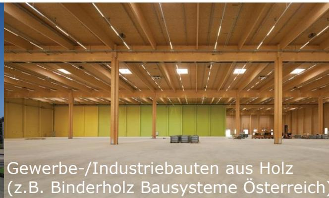
Gewerbe-/Industriebauten aus Holz (z.B. Binderholz Bausysteme Österreich)
